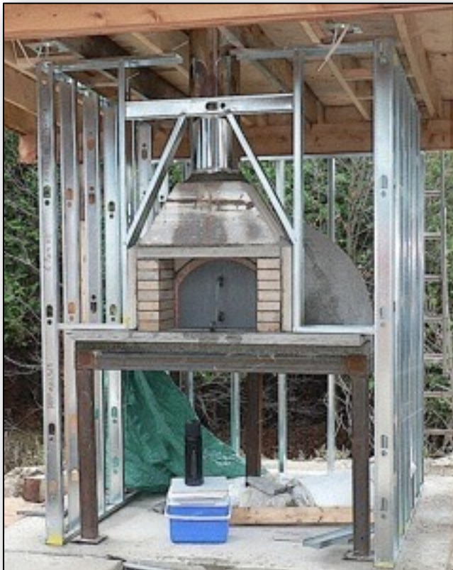
2.4. Custom metal stand with stud frame.
