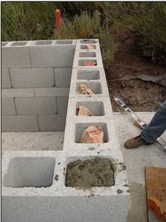
2.6. Filling the cores.
