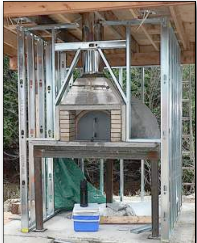
2.5. Custom metal stand with stud frame.
